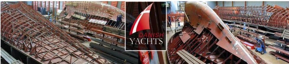
Рис. 5. Строительство стальных корпусов быстроходных судов компании «Danish Yachts»
